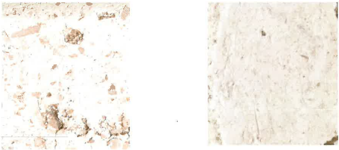
Abb. 18: Oberfläche des Aussenwandverputzes (links) und Oberfläche des Innenwandverputzes (rechts)
