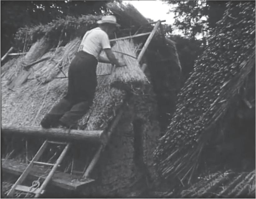
Abb. 5: Strohdachdecker bei der Arbeit (*Teilreparatur eines Strohdaches in Kölliken*).
