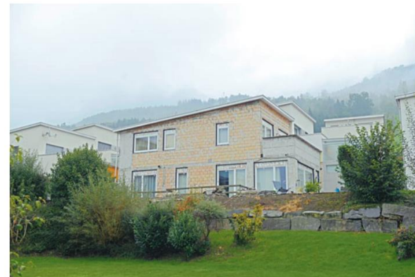
Wohnsitz im Rohbau – für ein Jahr dürfte der Hausbesitzer in eine andere Unterkunft ziehen.
