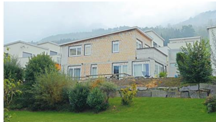
Wohnsitz im Rohbau – für ein Jahr dürfte der Hausbesitzer in eine andere Unterkunft ziehen.
