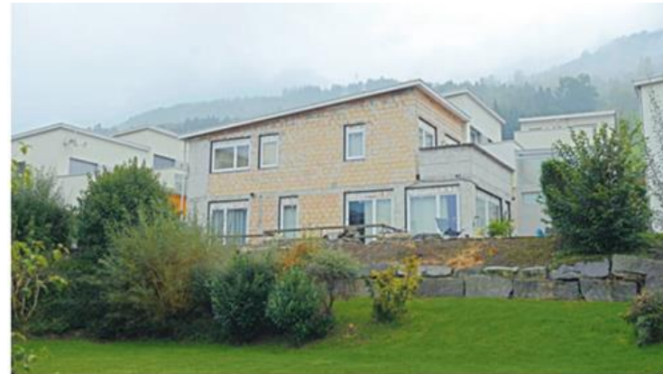
Wohnsitz im Rohbau – für ein Jahr dürfte der Hausbesitzer in eine andere Unterkunft ziehen.
