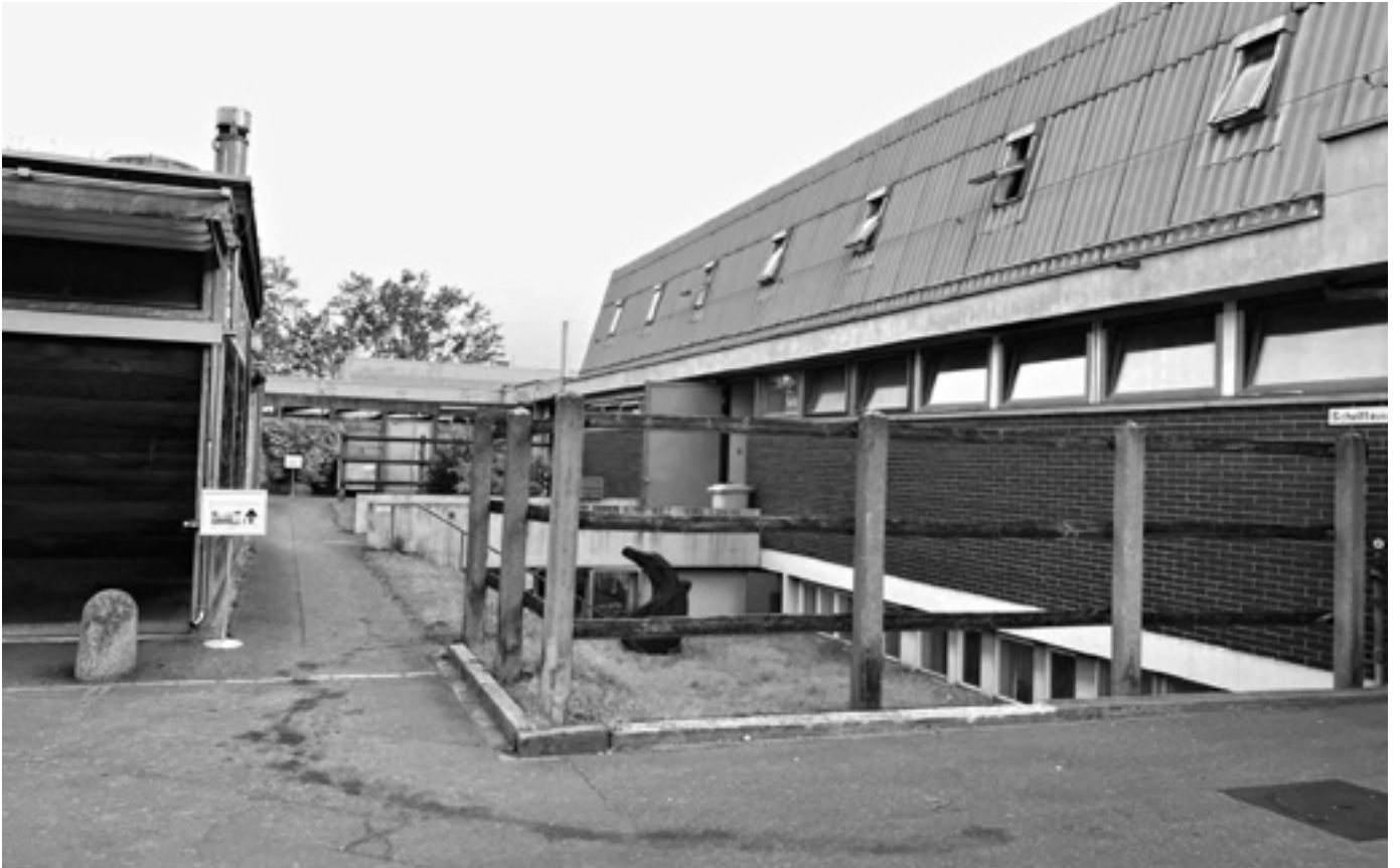
Teilansicht TSC Südwest, Stallungen/Untersuchung
